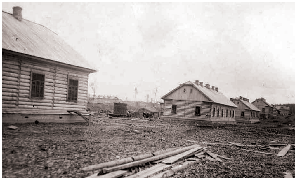
Строительство п. Перековка. 1930-е гг.
