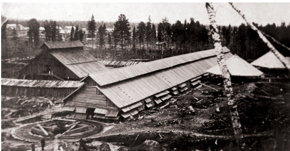
Строительство кирпичного завода в Остяко-Вогульске. 1933 г.
