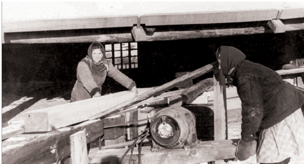
Строительство рыбоконсервного комбината. 1932-1934 гг.
